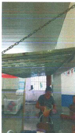
Figura 38 – REMOVER GRADE DE METAL E SUBSTITUIR POR GRADE DE ALUMÍNIO COM TELA MILIMÉTRICA.
