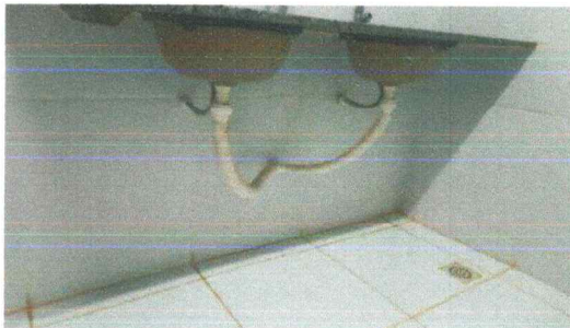
Figura 54 – SIFÕES PLÁSTICOS (SUBSTITUIR).
