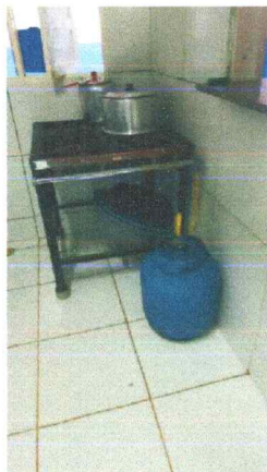
Figura 95 – FOGÃO COM BOTIJÃO NA COZINHA (CONSTRUIR ABRIGO EXTERNO).
