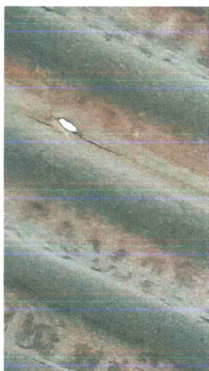
Figura 115 – TELHA FURADA (FOLHA DE CIBROCIMENTO ).
