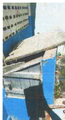
Figura 82 – DECOLOCAR PLACA DA COBERTURA E SUBSTITUIR FECHADURA.
