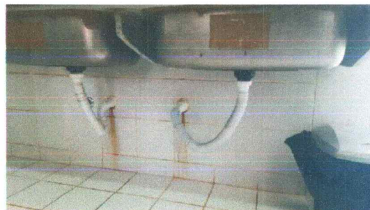
Figura 22 – SUBSTITUIÇÃO DE SIFÕES 2.
