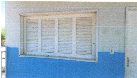
Figura 67 – REMOVER JANELA BASCULANDE E COLOCAR DE VIDRO 1.
