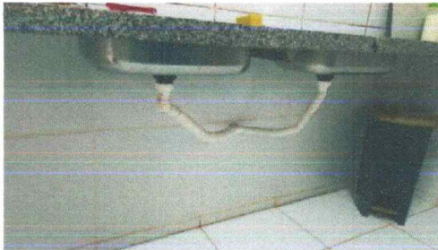
Figura 53 – SIFÕES INOX (SUBSTITUIR).
