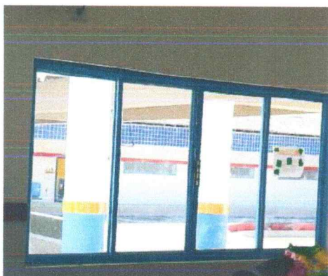
Figura 17 – APLICAÇÃO DE PELÍCULA NAS JANELAS.
