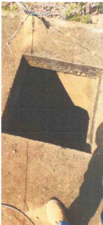
Acesso ao interior da caixa d'água
