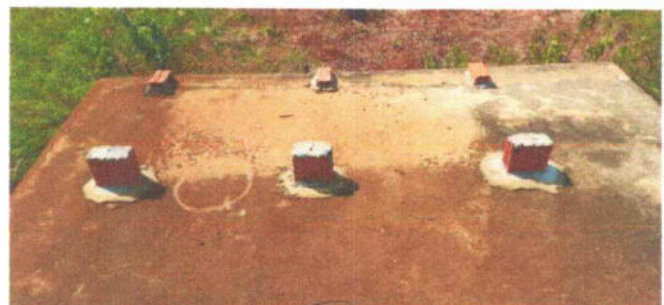
Blocos chumbados sobre laje
