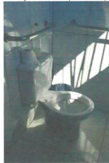
Tampa (Reparo hidráulico)
