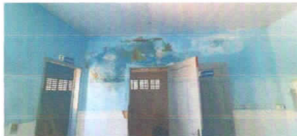
Infiltrações (Conforme Memória de Cálculo)
