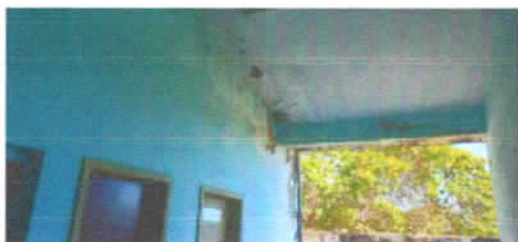
Infiltrações (Conforme Memória de Cálculo)
