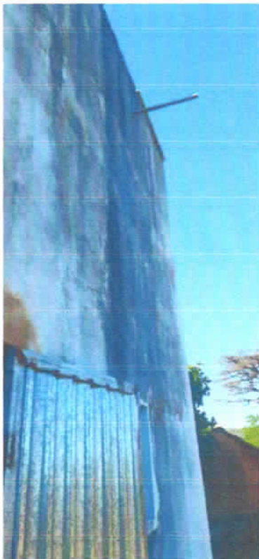
Infiltrações (impermeabilização)
