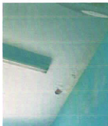
Infiltrações (Conforme Memória de Cálculo)
