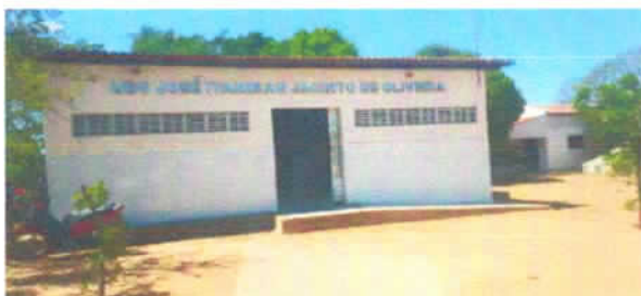
Janelas (Substituição os Cobogós)
