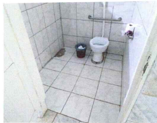
FOTO 16 – BOX DE BANHEIRO
