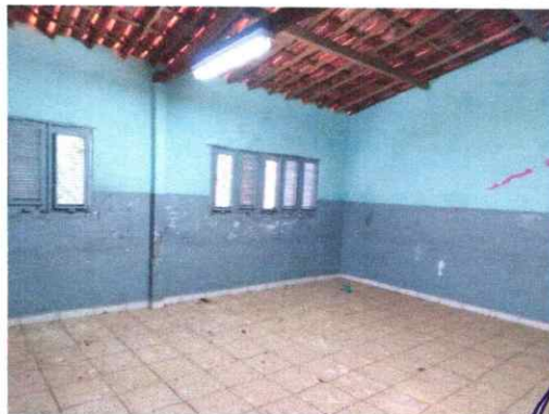
FOTO 17 – SALA DO SEGUNDO ANDAR
