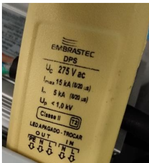
Foto 9 - Dispositivo Protetor de Surto (DPS)
