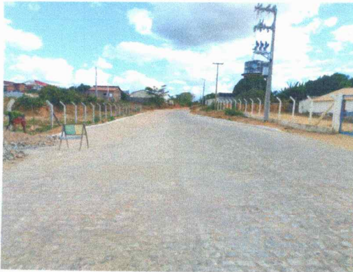
FOTO 03 – RUA RAIMUNDO RODRIGUES TORRES
