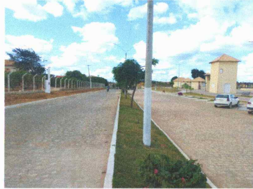
FOTO 02 – RUA RAIMUNDO RODRIGUES TORRES
