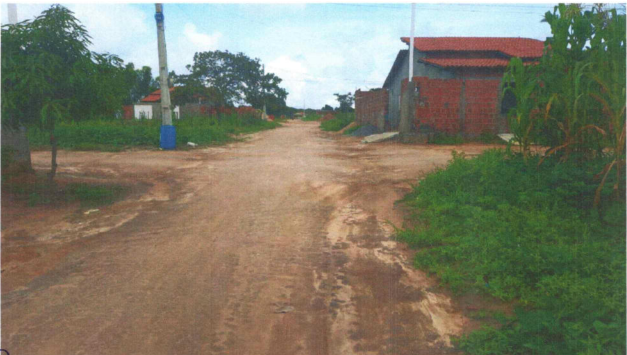
Figura 113 – RUA DA LARANJA – TRECHO 02.
