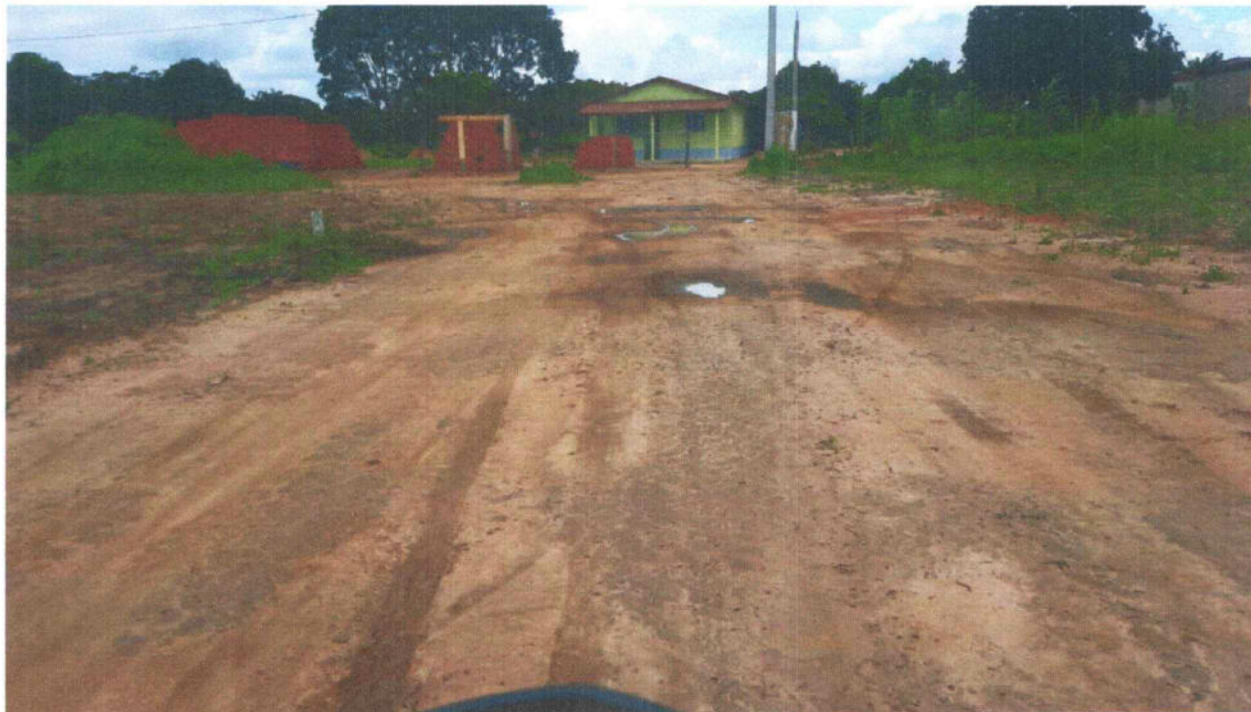
Figura 120 – RUA DA LARANJA – TRECHO 02.
