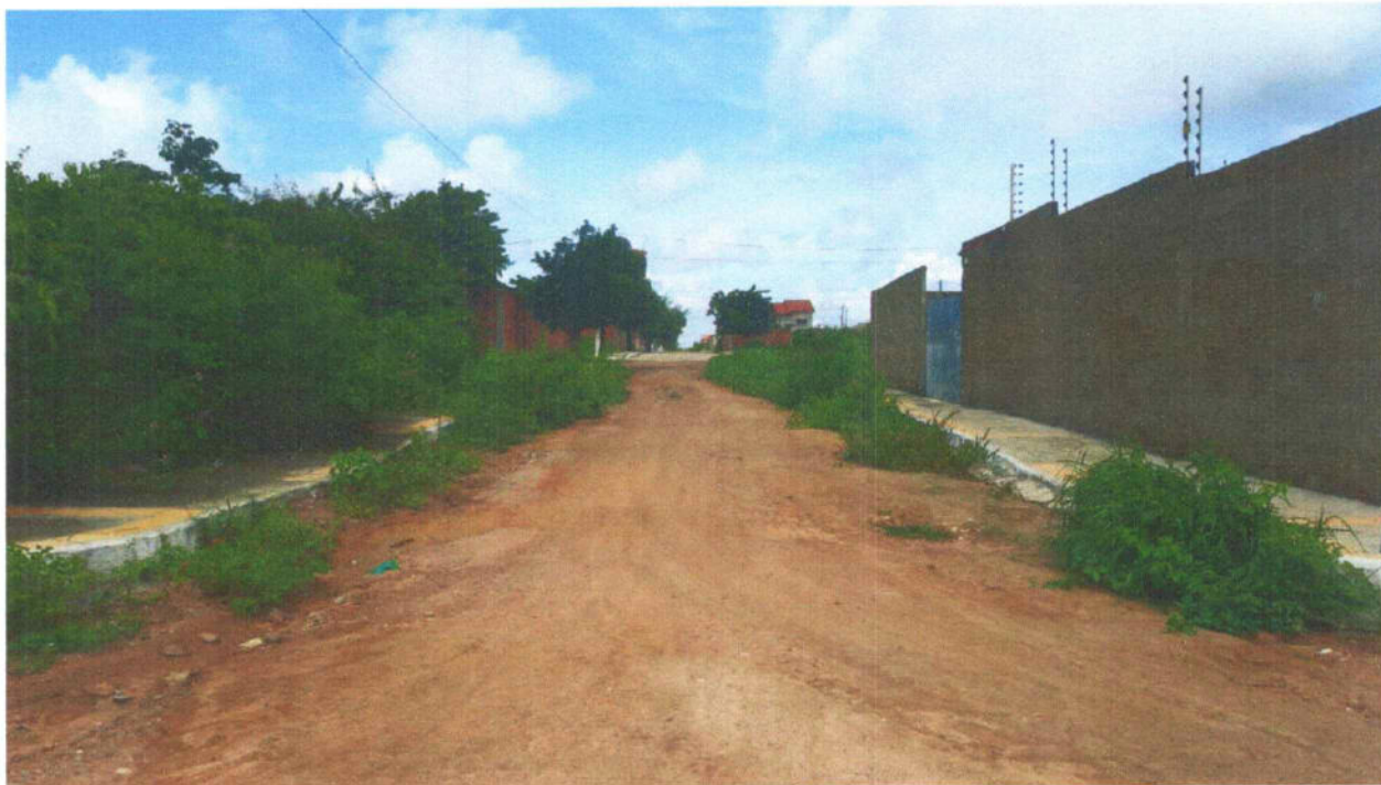
Figura 108 – RUA DA LARANJA – TRECHO 01.
