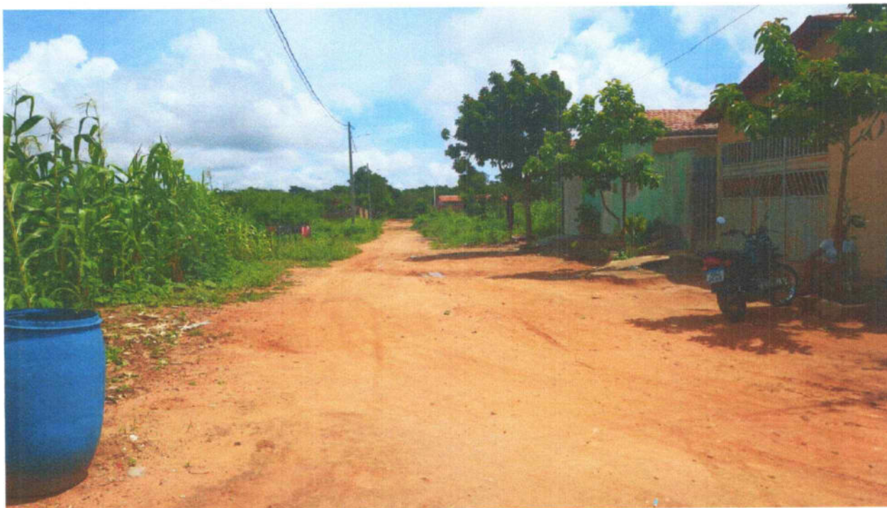
Figura 32 – RUA JÚLIO FERREIRA CAVALCANTE.
