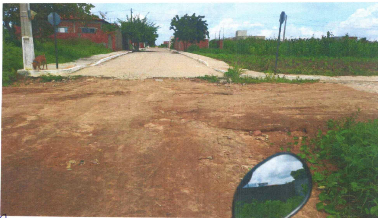
Figura 109 – RUA DA LARANJA – TRECHO 01.
