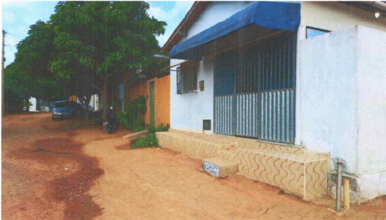
Figura 77 – RUA ANTÔNIO DE FREITAS.
