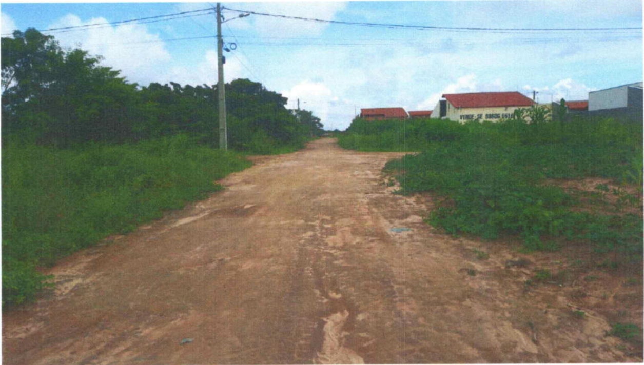
Figura 110 – RUA DA LARANJA – TRECHO 02.
