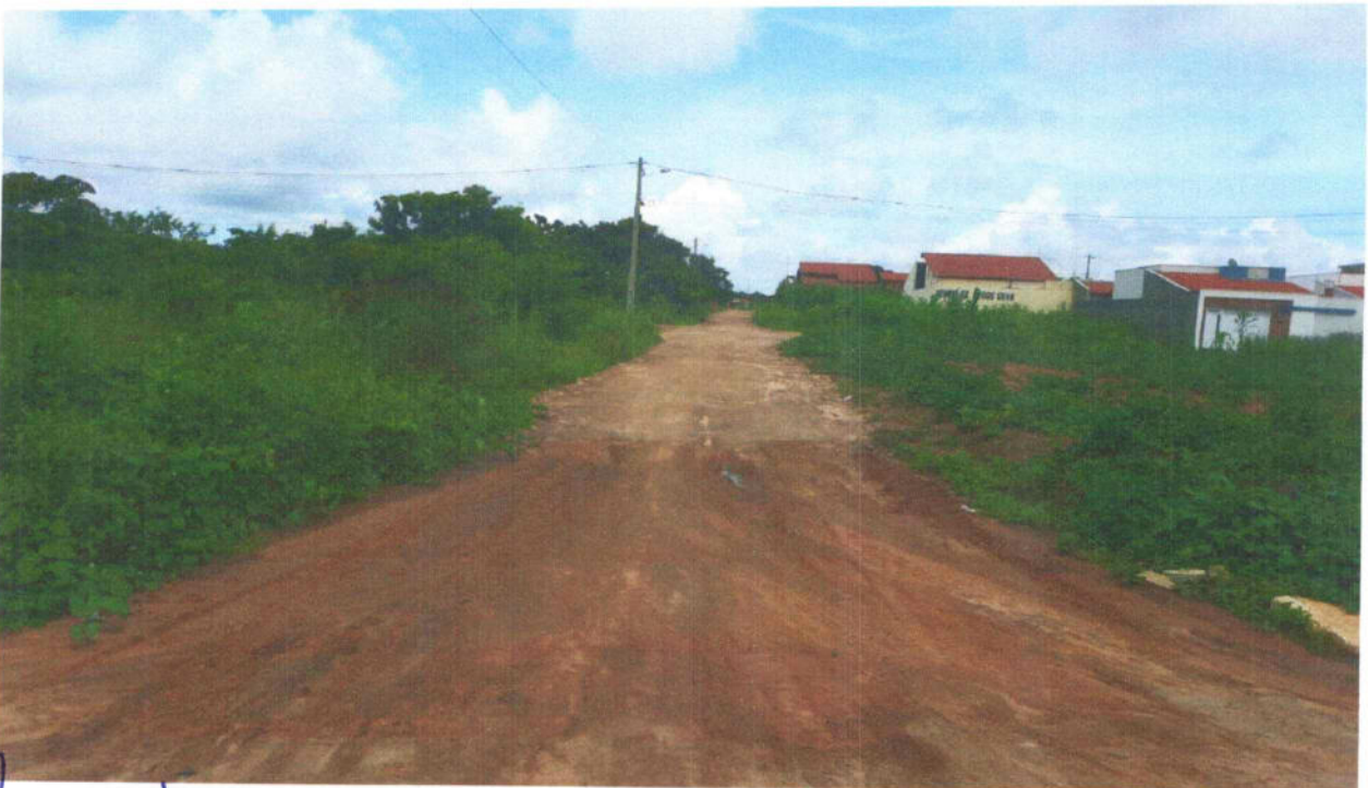
Figura 111 – RUA DA LARANJA – TRECHO 02.
