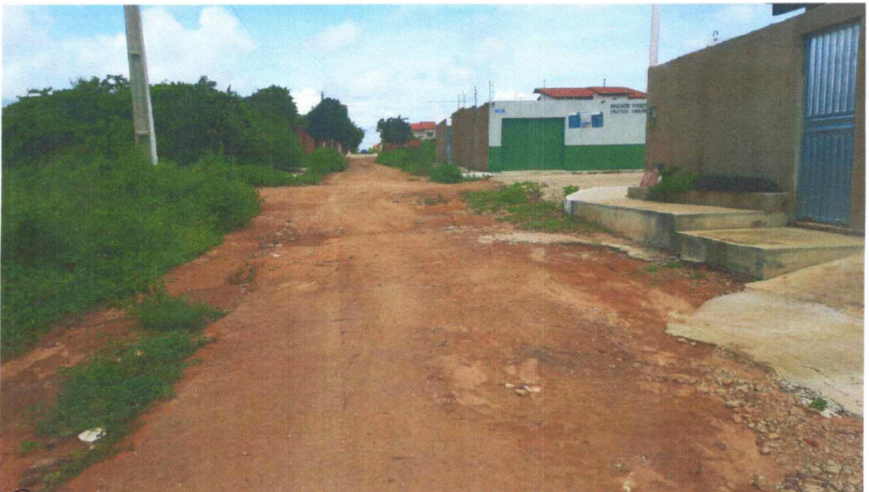
Figura 107 – RUA DA LARANJA – TRECHO 01.
