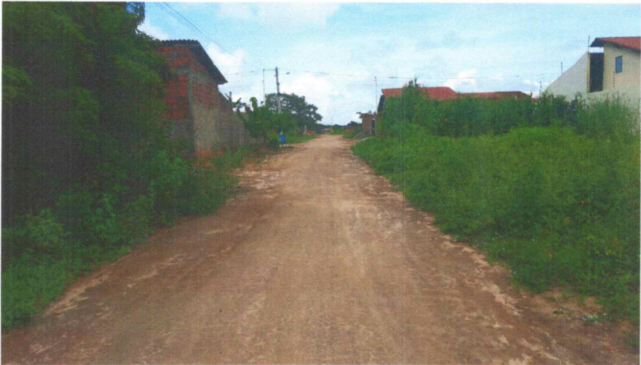
Figura 112 – RUA DA LARANJA – TRECHO 02.
