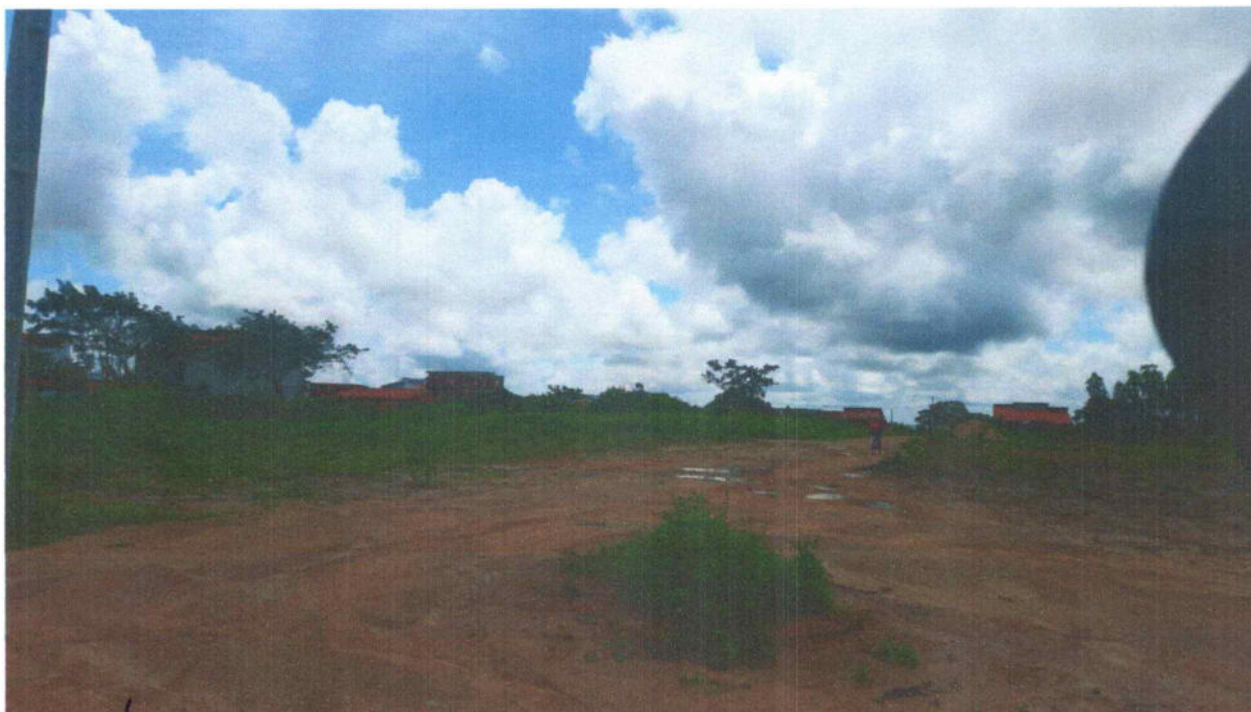
Figura 121 – RUA DA LARANJA – TRECHO 02.
