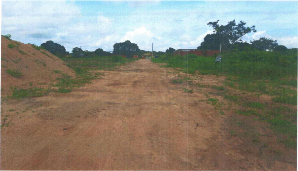
Figura 116 – RUA DA LARANJA – TRECHO 02.
