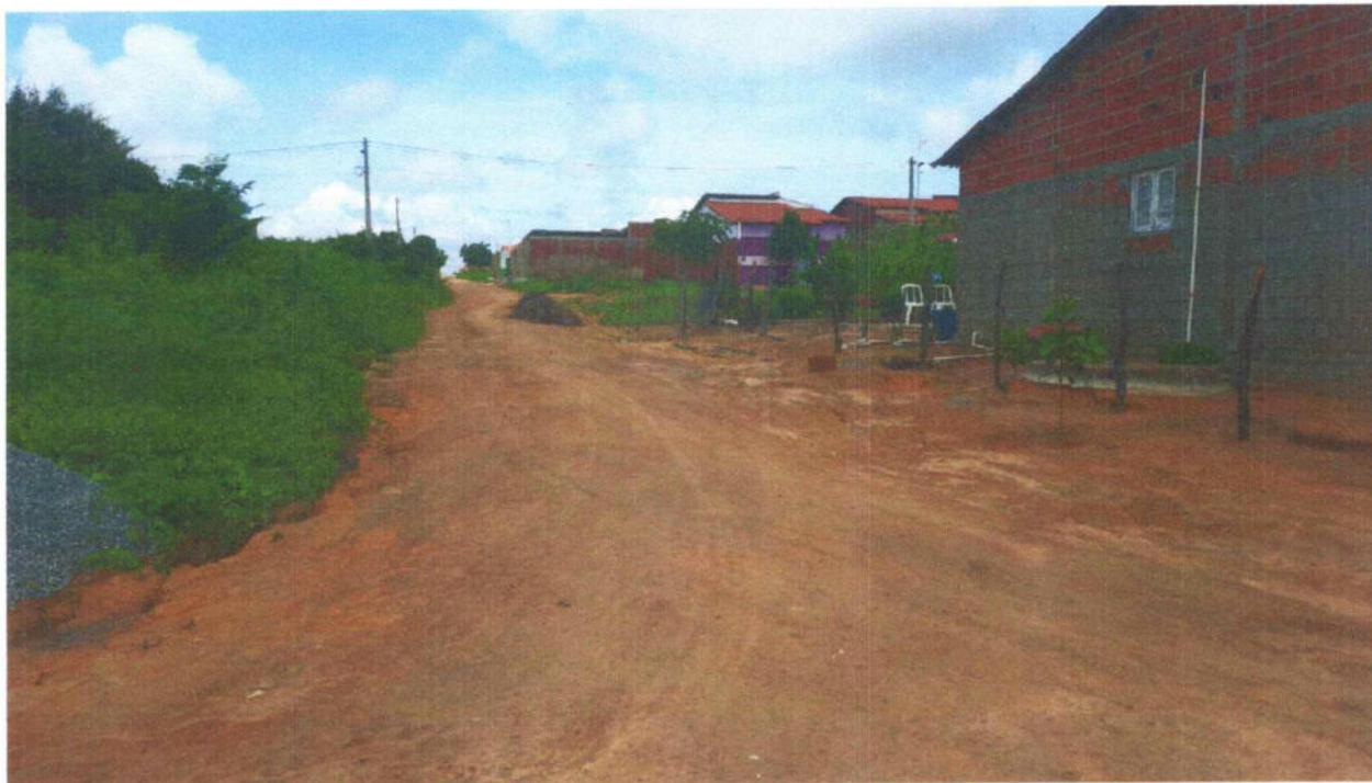
Figura 104 – RUA DA LARANJA – TRECHO 01.
