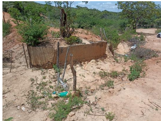
FOTO 02 – DRENAGEM SÍTIO ARROJADO
