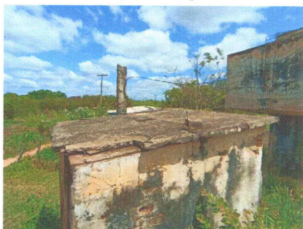
Laje do Abrigo
