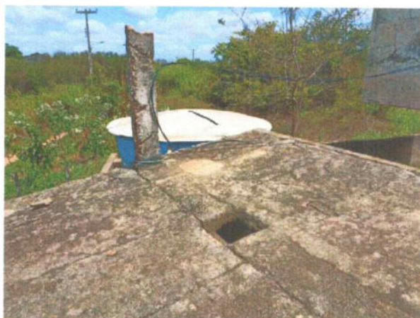
Laje do Abrigo
